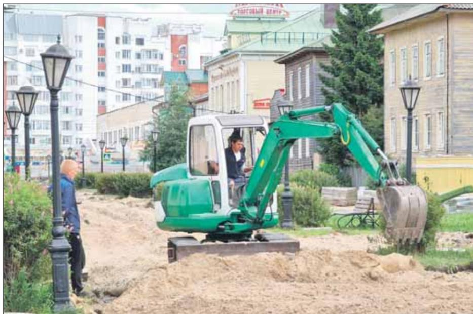
на участках между улицами Поморской и Иоанна Кронштадтского предусматривает выравнивание грунта, устранение провалов, регулировку высотного положения колодцев. Трубы городских коммунальных систем будут «спрятаны» в декоративные короба.
