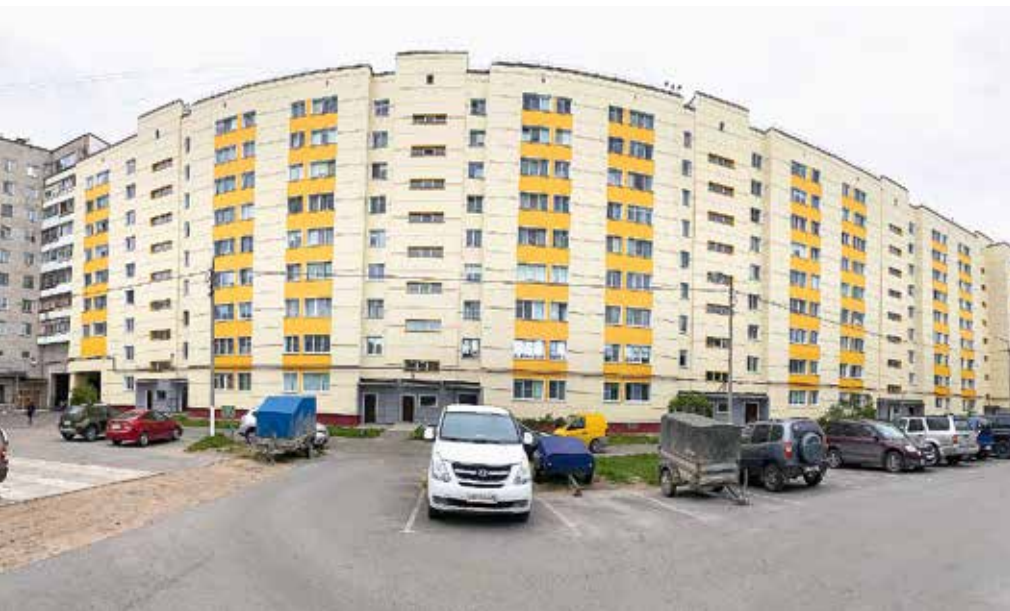
ПОДРЯДЧИК, ООО «РТ-СТРОЙ», УТЕПЛИЛ ФАСАД МНОГООКВАРТИРНОГО ДОМА В СЕВЕРОВДВИНСКЕ. ЭТО ПОЗВОЛИТ УЛУЧШИТЬ ТЕПЛОТЕХНИЧЕСКИЕ ХАРАКТЕРИСТИКИ НАРУЖНЫХ СТЕН ИЗ СИЛИКАТНОГО КИРПИЧА.
