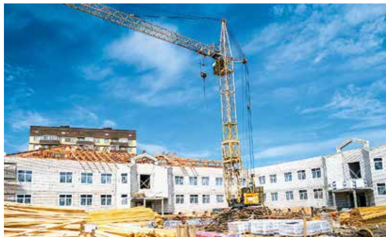
ДЕТСКИЙ САД НА УЛИЦЕ ПЕРВОМАЙСКОЙ В АРХАНГЕЛЬСКЕ ООО «СТРОЙ ЦЕНТР» ВОЗВОДИТ В РАМКАХ НАЦИОНАЛЬНОГО ПРОЕКТА «ДЕМОГРАФИЯ». СРОК ЗАВЕРШЕНИЯ РАБОТ – 1 ОКТЯБРЯ 2021 ГОДА.
