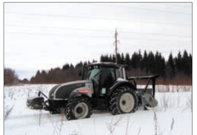
Механическую расчистку трассы энергетики выполняют с помощью трактора-кустореза.
