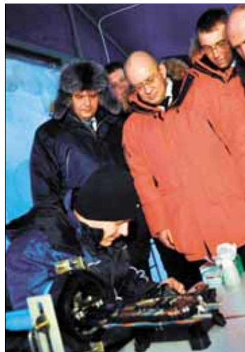
Сварка последней муфты в селе Тельвиска.
